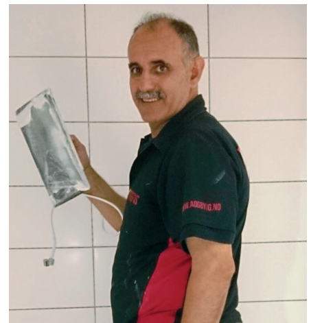
Cemal Barcin sjekker at fugingen er som den skal være.
